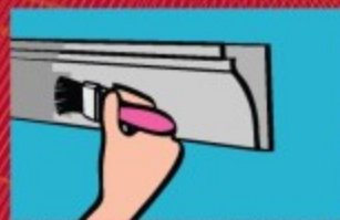
Executarea cojirii profilelor cu adeziv diluat (de 2-3 ori)
